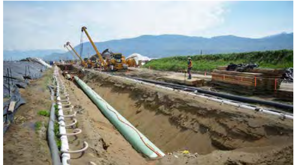
Οι εργαζόμενοι απεικονίζονται να τοποθετούν ένα σωλήνα κατά την κατασκευή του έργου επέκτασης του αγωγού Trans Mountain στο Abbotsford, BC, το Μάιο του 2023
